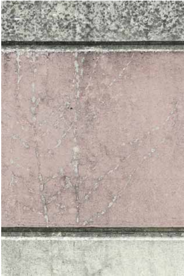
Justizanstalt Stein: Außenmauer West
