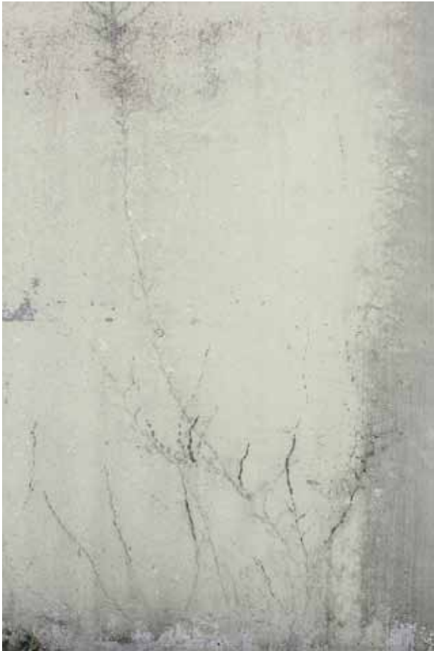
Justizanstalt Stein: Außenmauer West
