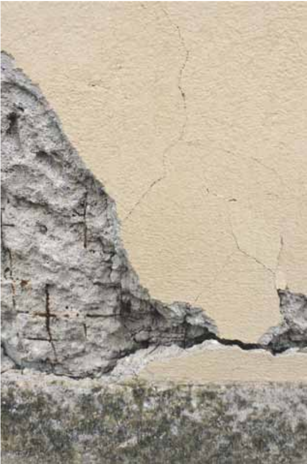
Justizanstalt Stein: Außenmauer West
